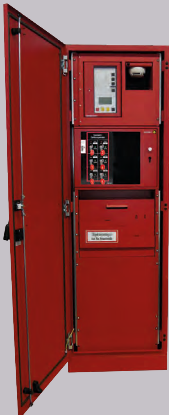
FAS-AT Beispielhaft ausgebaut
