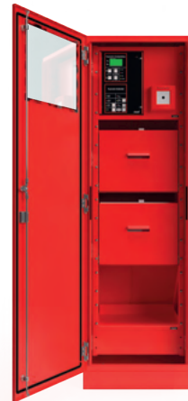
Feuerwehr-Anlaufstation (FAS) in schmaler Ausführung
